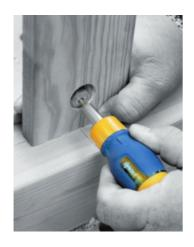
Используя подготовленные технологические отверстия, соединяйте детали при помощи крепежа.
